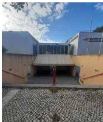
Instalação de corrimão e toldo no Centro de Saúde do Forte da Casa
