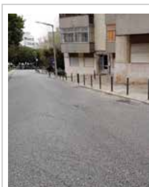
Colocação de Pilaretes
