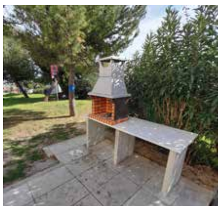
Instalação de grelhador comunitário na Rua do Clube Académico de Desportos.
