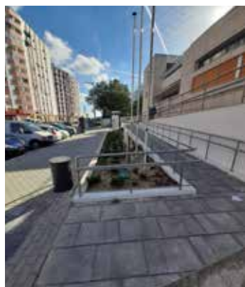
Rampa no Centro de Saúde da Póvoa de St. a Iria (obra da Câmara Municipal)
