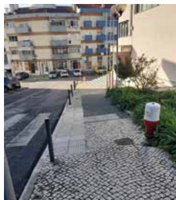
Rampa de acesso ao Pavilhão Municipal do Forte da Casa (obra da Câmara Municipal)
