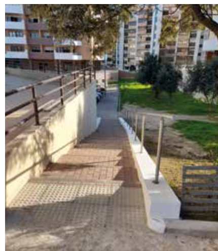
Avenida Casal da Serra (obra da Câmara Municipal)
