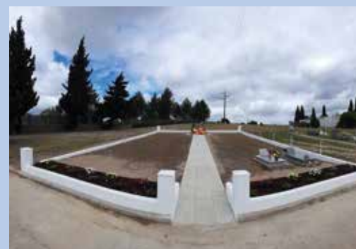
Arranjo do talhão dos autarcas e construção do Memorial de homenagem aos autarcas da freguesia no Cemitério Municipal da Quinta da Piedade
