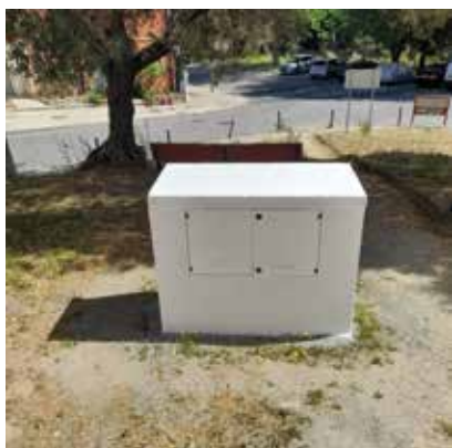
Construção de caixas para contadores
