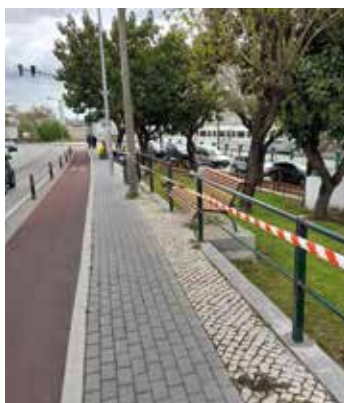
Instalação de corrimão na Av. a Marítimos da Póvoa
