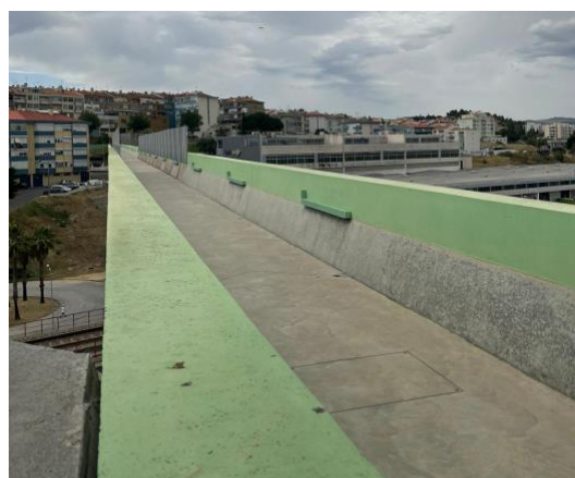
Anexo 2 – Passagem Pedonal Superior do Forte da Casa
